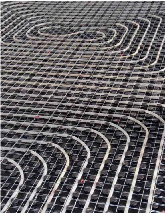
Il riscaldamento degli appartamenti è ottenuto mediante un impianto a **pannelli radianti a pavimento** atti a garantire il benessere e la vivibilità degli spazi. Per l'integrazione della temperatura nei bagni sono installati radiatori tipo termoarredo alimentati a bassa temperatura.
